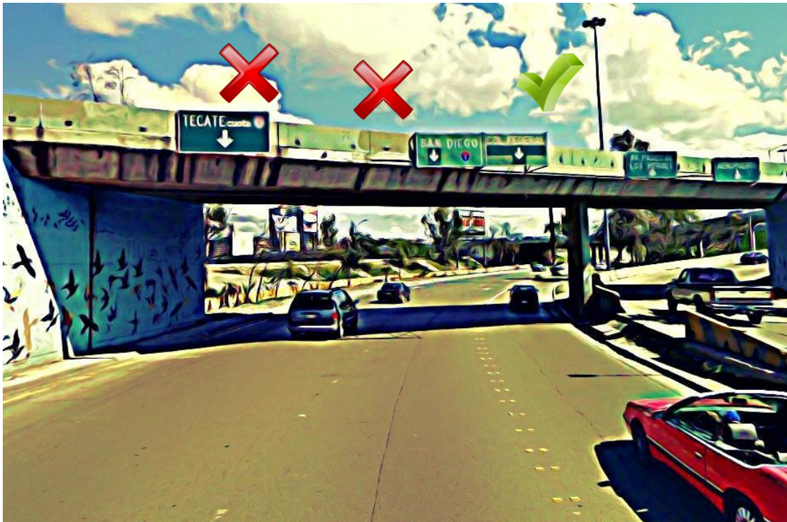
Figura 11. Imagen de la Calle Segunda Intersecando el Puente Vehicular
